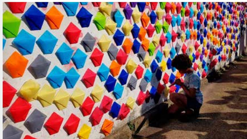
Na oficina em Ferrol, Galícia, jovens construíram um muro verde em um espaço residual no centro da cidade, como uma pequena semente por uma cidade mais sustentável. Essas estruturas coloridas são feitas com material geotêxtil, e dentro delas são colocadas bombas de sementes que, ao germinarem, formam um muro verde
