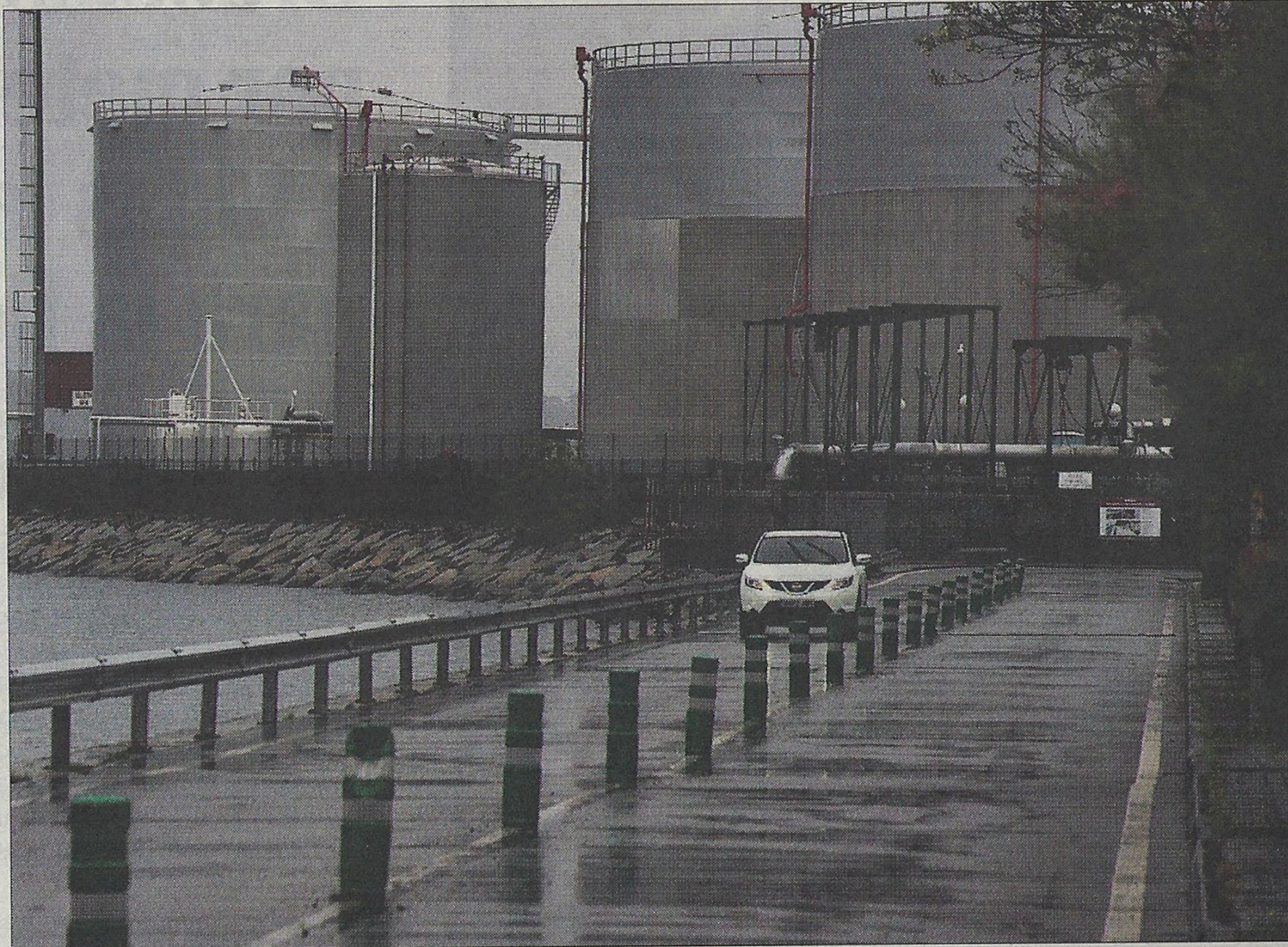
El vial de orillamar donde se construirá el paseo marítimo, una demanda histórica. // Iñaki Abella
